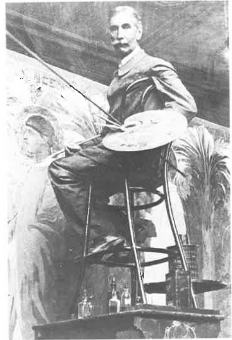
Maurice Réalier-Dumas peignant sur son échafaudage
